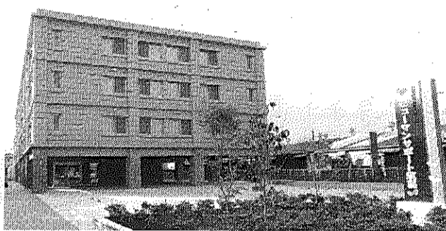
▲介護付有料老人ホーム「ヒューマンサポート筑西」外観
